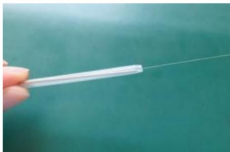
图 2-11 安装热缩管
